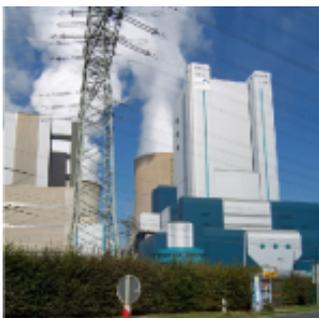
*Moderne Kohlekraftwerke wie der neue 1.000-MW-Block im Braunkohlekraftwerk Niederaußem erreichen dank besonders effizienter Anlagentechnologie einen Wirkungsgrad von 43 %*
